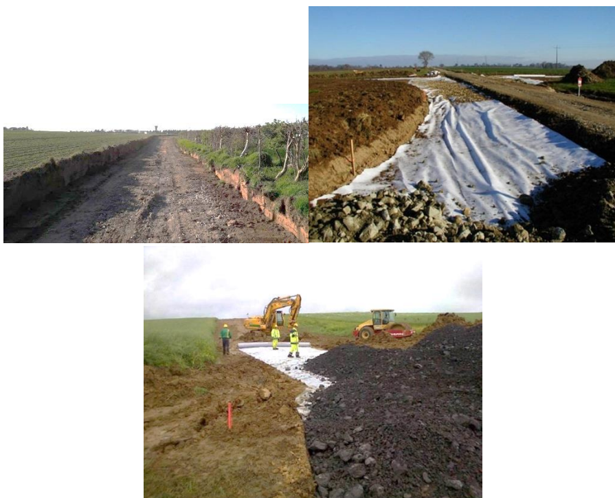
Figure 2: étapes de rénovation d'un chemin de type sableux
