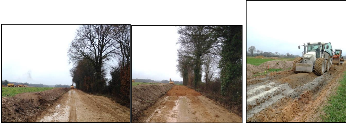
Figure 3 : étapes de rénovation d'un chemin de type argileux (photos issues de la société Arlaud Iribarren TP)
